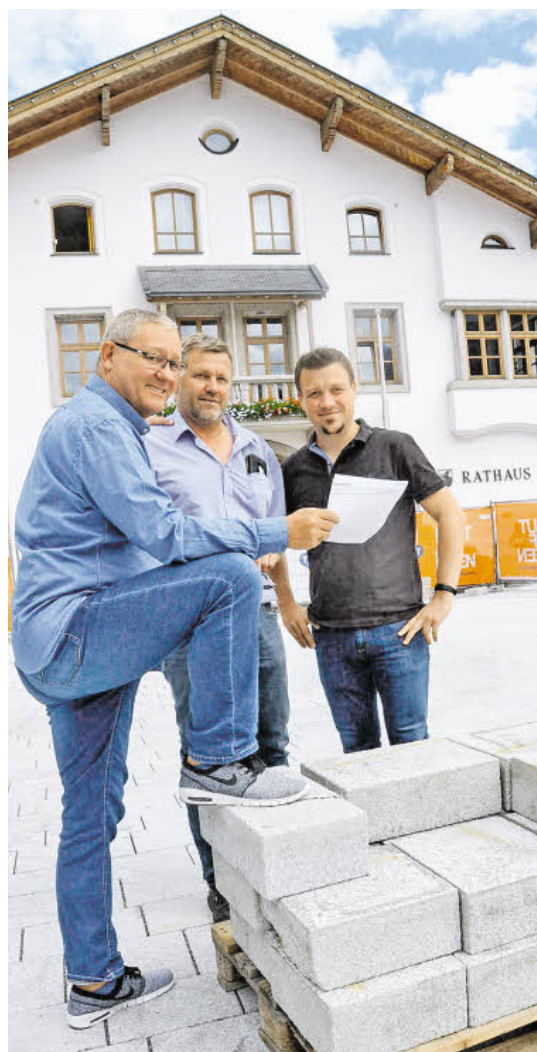
Anfang dieser Woche bei der Baustellen-Besichtigung (v. l.): Bgm. Wolfgang Viertler, Wolfgang Kogler und Harald Rainer.
