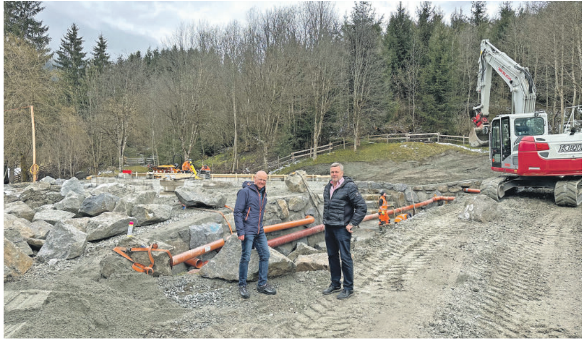
Baustellenbesichtigung: Vize-Bgm. Volker Kalcher und Bauhofleiter Wolfgang Kogler.
