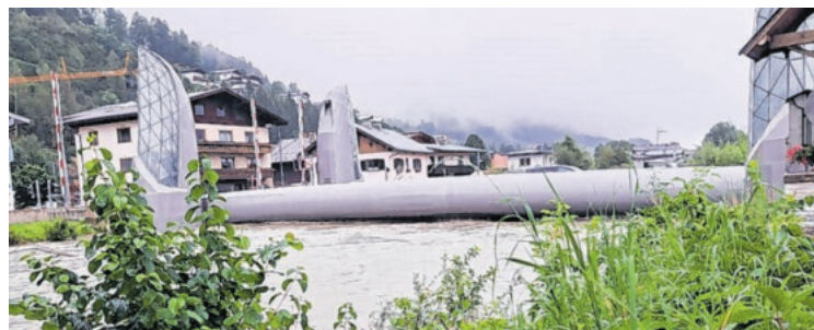
Dieses Bild von der hochwasserführenden Salzach (4,89 Meter) entstand am frühen Vormittag, später stieg der Pegel noch auf fast 5,50 Meter an. Die Brücke musste angehoben werden. BILD: NOTHDURFTER
