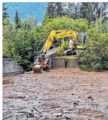
Wildbach- und Lawinerverbauung (WLV) im Einsatz. BILD: PRIVAT
